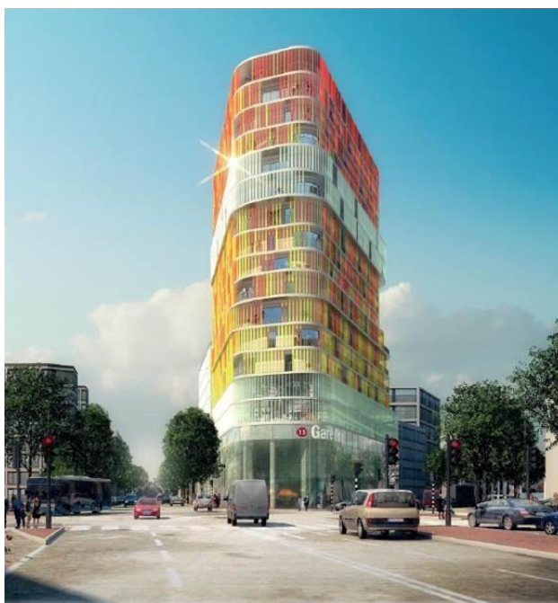
Bâtiment surplombant la future gare d'Issy RER du Grand Paris Express ©Icade et Architecture Studio
